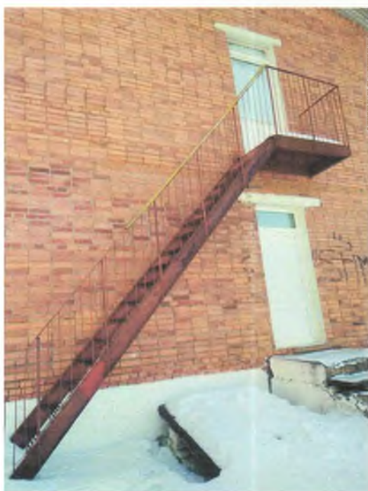
Пожарный (запасной) вход подготов. гр.
